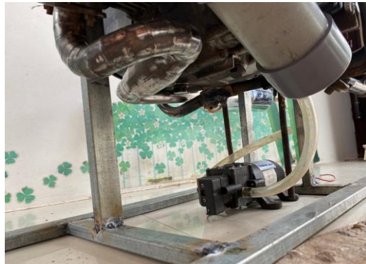
Hình 7. Thi công hệ thống xả khí thải
